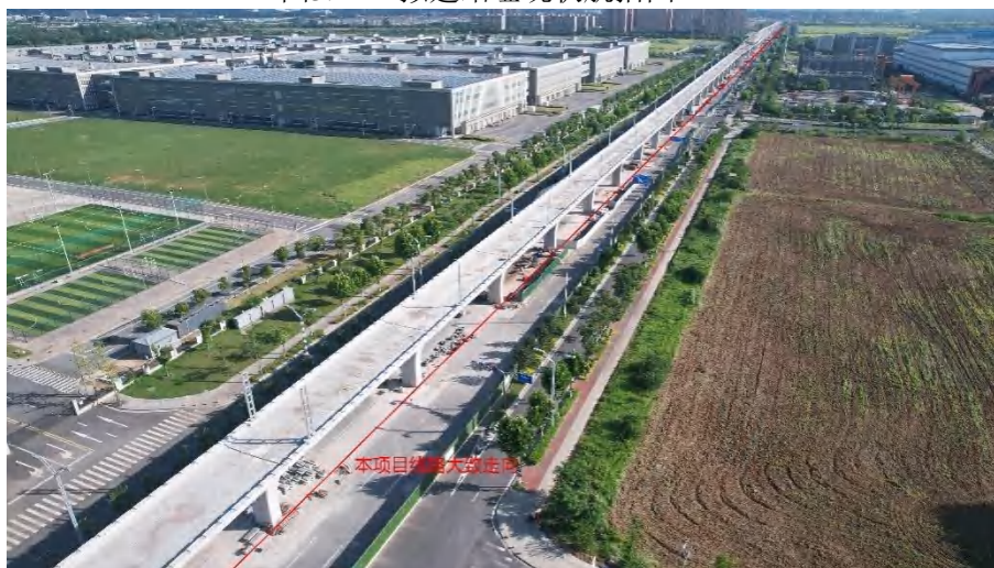
图3.2-2 本项目输电线路沿线现状航拍图
