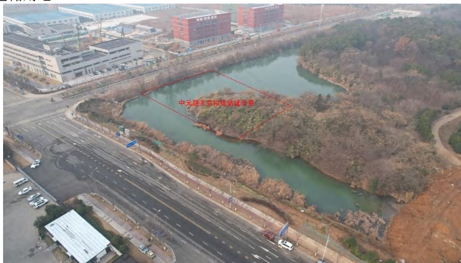
图3.2-1 拟建站址现状航拍图
